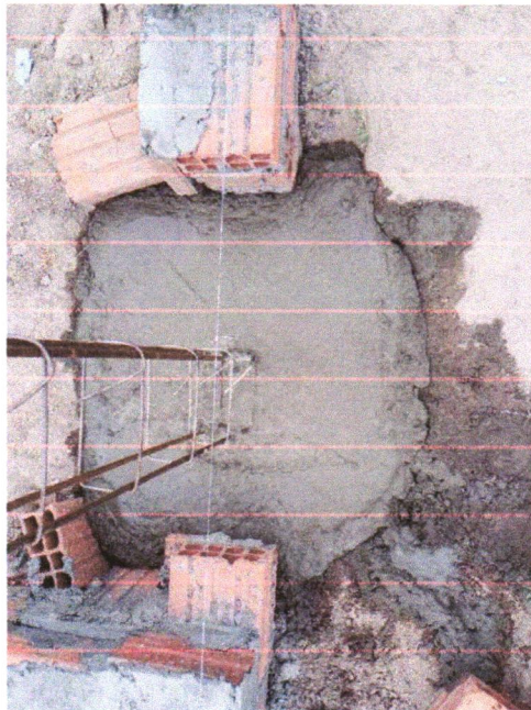
FOTO 11- (COMPOSIÇÃO REPRESENTATIVA) EXECUÇÃO DE ESTRUTURAS DE CONCRETO ARMADO, PARA EDIFICAÇÃO HABITACIONAL UNIFAMILIAR TÉRREA (CASA EM EMPREENDIMENTOS), FCK = 25 MPA
