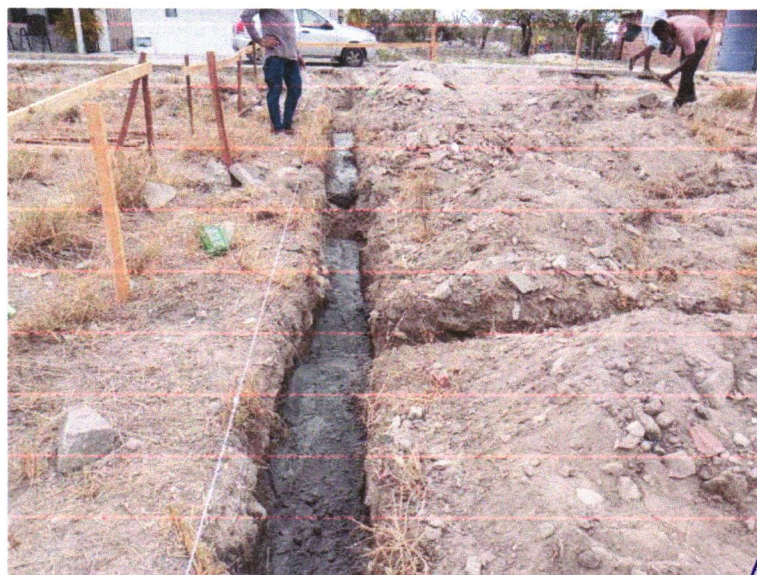
FOTO 06 – LASTRO DE CONCRETO MAGRO, APLICADO EM BLOCOS DE COROAMENTO OU SAPATAS, ESPESSURA DE 3 CM
