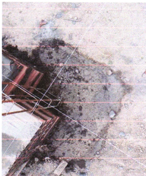
FOTO 10- (COMPOSIÇÃO REPRESENTATIVA) EXECUÇÃO DE ESTRUTURAS DE CONCRETO ARMADO, PARA EDIFICAÇÃO HABITACIONAL UNIFAMILIAR TÉRREA (CASA EM EMPREENDIMENTOS), FCK = 25 MPA
