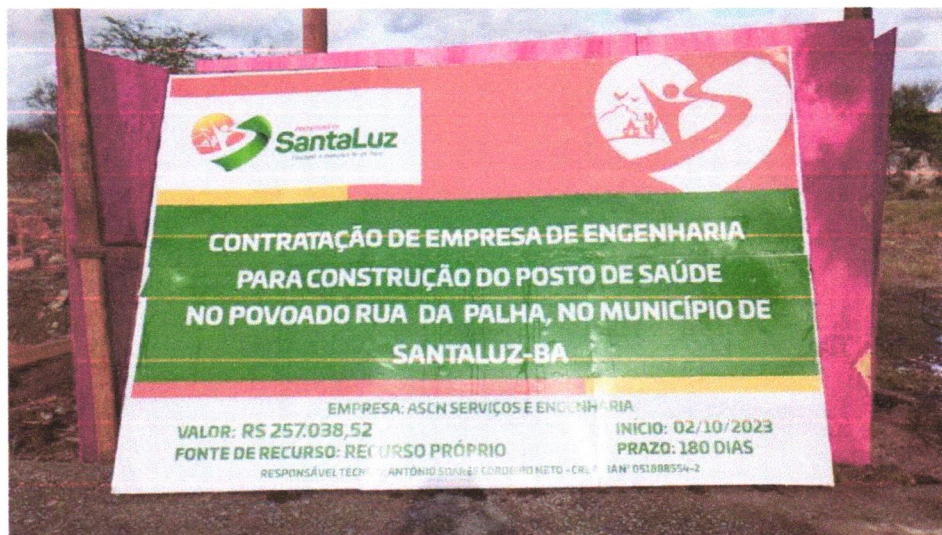
FOTO 01 – Placa de obra em chapa aço galvanizado, instalada
