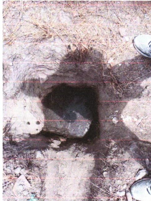
FOTO 07 - LASTRO DE CONCRETO MAGRO, APLICADO EM BLOCOS DE COROAMENTO OU SAPATAS, ESPESSURA DE 3 CM
