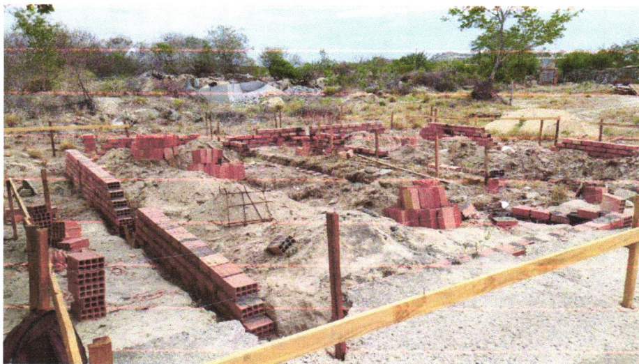
FOTO 08 - LOCALIZAÇÃO CONVENCIONAL DE OBRA, UTILIZANDO GABARITO DE TÁBUAS CORRIDAS PONTALETADAS A CADA 2,00M
