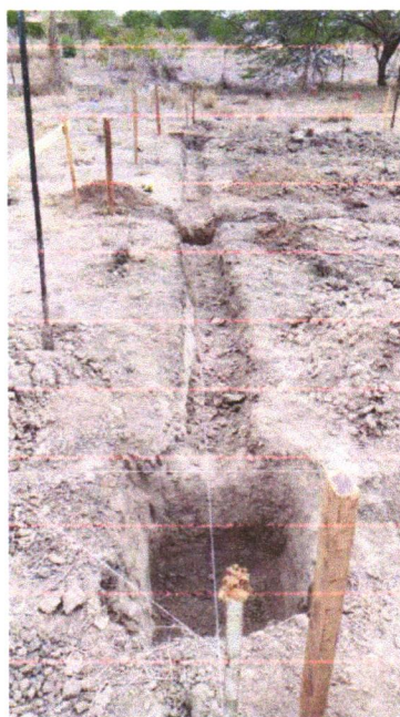
FOTO 04 - ESCAVAÇÃO MANUAL DE VALA PARA VIGA BALDRAME (INCLUINDO ESCAVAÇÃO PARA COLOCAÇÃO DE FÔRMAS). AF_06/2017
